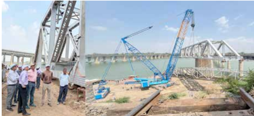
પડકારજનક બનાવ્યું: વર્ષ ૧૯૧૩માં બ્રિટિશ શાસન દરમિયાન બંધાયેલો આ બ્રિજ મહિસાગર નદી પર સ્થિત એક મહત્વપૂર્ણ રેલ્વે માળખું છે. નદીમાં આખું વર્ષ પાણીનો પ્રવાહ રહેતો હોવાને કારણે આ બ્રિજ પર રિ-ગર્ડરિંગ નું કામ અત્યંત પડકારજનક હતું. પ્રોજેક્ટ હેઠળ ૬૦.૫ મીટર લાંબા તથા આશરે ૩૨૦ ટન
